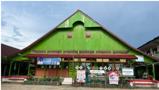
Gambar 9 Bentuk Atap Perisai Sumber: Dokumentasi Pribadi NEM 2026
