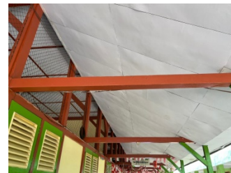
Gambar 4 Kolom Bangunan Bagian Luar
