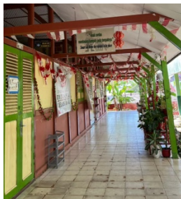
Gambar 6 Bentuk Teras/Koridor Bagian Samping Kanan Sumber: Dokumentasi Pribadi NEM 2026
