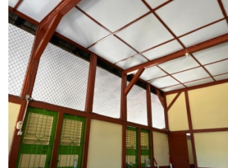
Gambar 3 Kolom Bangunan Bagian Dalam
