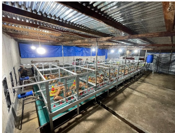
Gambar 5. Hasil pembangunan kandang colony dengan cooling pad dan exhaust fan .
