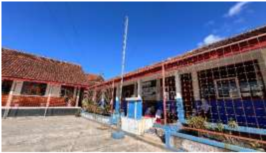
Gambar 5 : Kondisi bangunan sekolah
