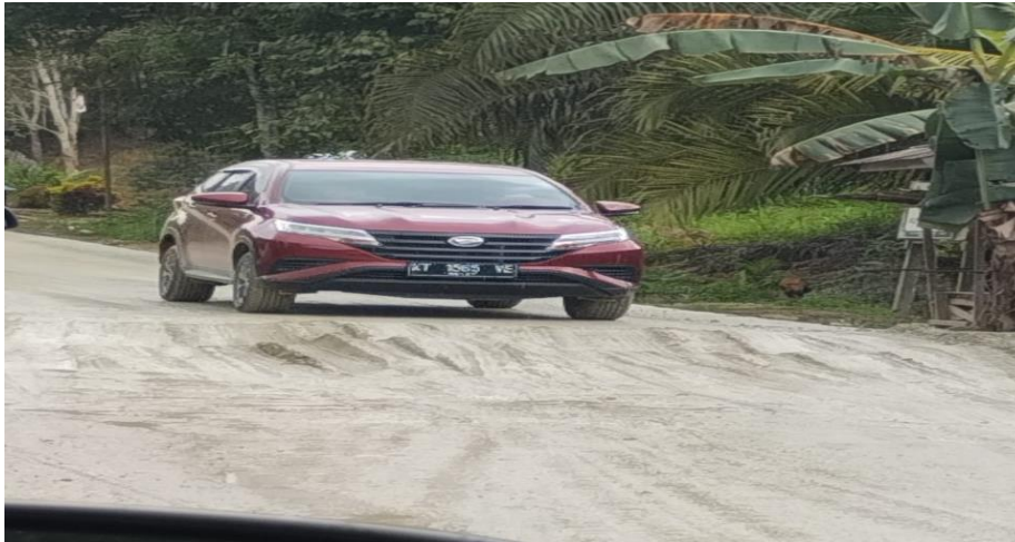
Gambar 4. Dokumentasi Jalan Utama Penajam Paser Utara yang sedang pelebaran dan Pengecoran. Sumber: Dokumentasi Pribadi Peneliti
