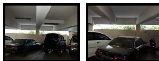
Gambar 1 Keadaan ventilasi di lokasi I
