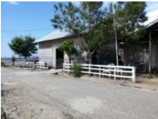
Gambar 9. Gudang Tempat Menyimpan Rumput Laut, Sumber: Dokumentasi Peneliti, 2017
